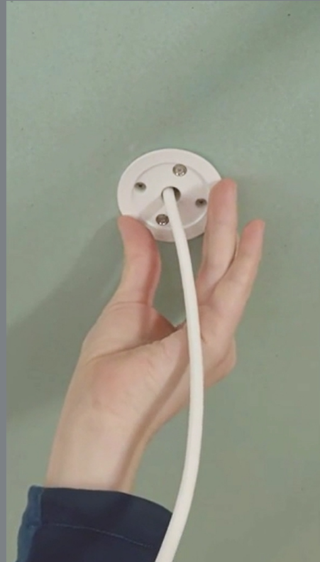
3 ВСТАВЬТЕ АДАПТЕР В ОТВЕРСТИЕ. ПРОВОД ДОЛЖЕН БЫТЬ ЗАФИКСИРОВАН С УЧЕТОМ ДЛИНЫ СВЕСА СВЕТИЛЬНИКА
