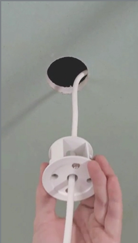
2 ЗАФИКСИРУЙТЕ ПРОВОД ОТ СВЕТИЛЬНИКА В АДАПТЕРЕ ПРЕДВАРИТЕЛЬНО ПОДКЛЮЧИВ К ВЫВОД ПИТАНИЮ
