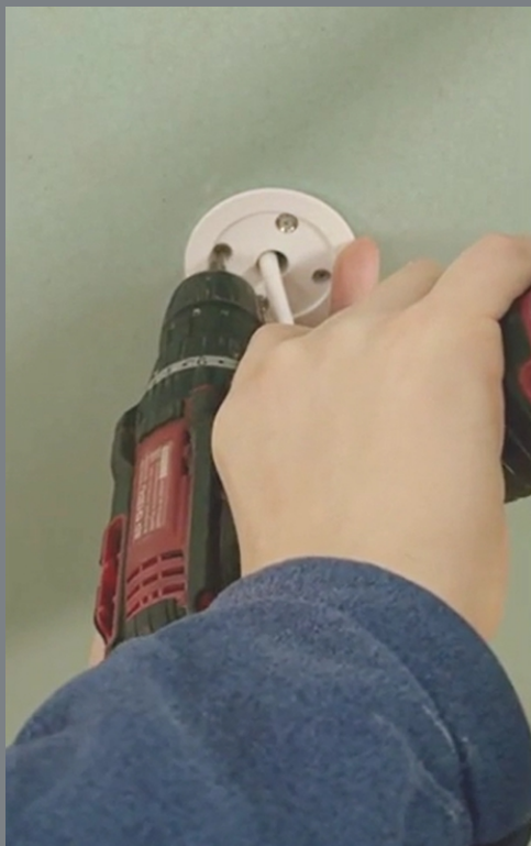
4 ЗАКРУТИТЕ ВИНТЫ С ПОМОЩЬЮ ИНСТРУМЕНТА ДО ФИКСАЦИИ АДАПТЕРА К ЛИСТУ ПОТОЛКА
