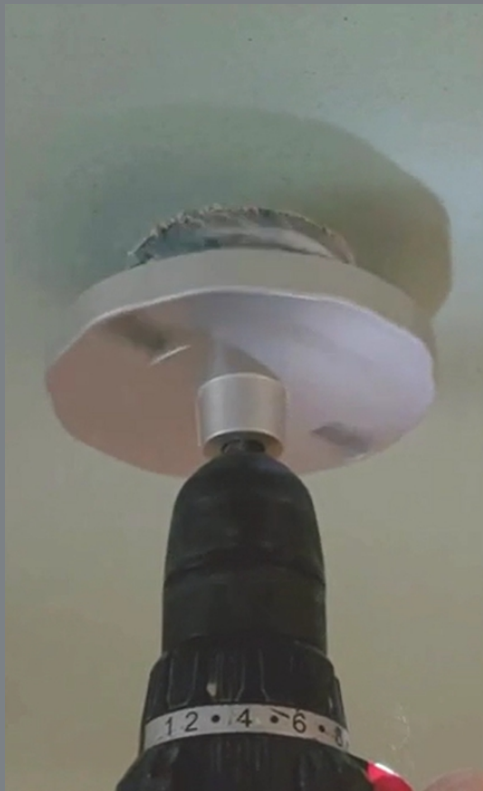
1 ПРОСВЕРЛИТЕ ОТВЕРСТИЕ 55 MM
